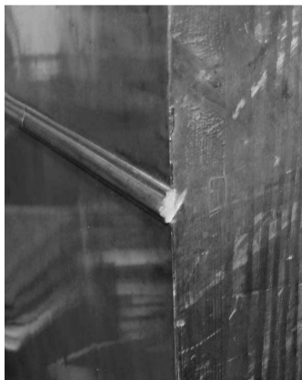
Anche la cornicetta sul fianco è inserita ad incastro e non è solo incollata.
